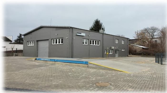
Fot. Nowo wybudowany budynek Punktu Selektywnego Zbierania Odpadów Komunalnych przy ulicy Starobuskiej w Chmielniku
